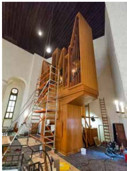
Ausbau der Pfeifen
